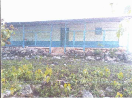
Foto 3: Pintura en muros interiores y exteriores del centro educativo.
