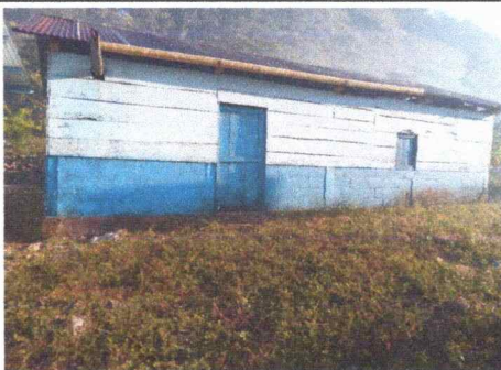
Foto 5: Cambio de estructura y cubierta en cocina.
