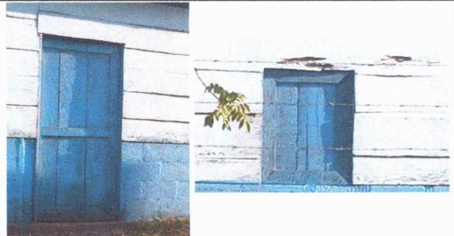
Foto 6: Cambio de puerta y ventanas.
