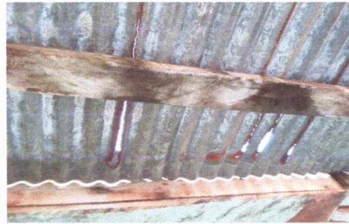
Foto 4: Cambio de techo y viga de metal.
