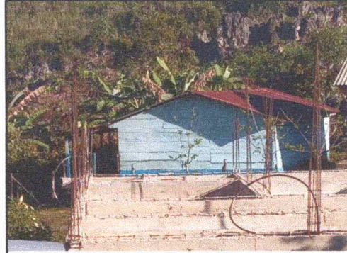
Foto 2: Estructura de techo.
